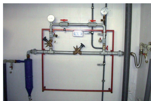
Obr. 7 Kontrolní výměnná trubka (kontrola stavu vnitřního povrchu) a tangenciální odlučovač EKOMAG
