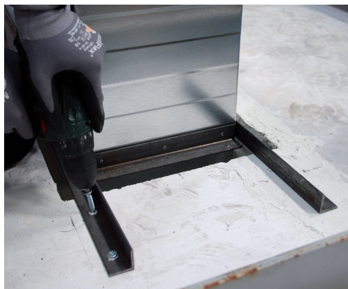
Obr. 7 Vnější vyztužení tvořené L-profilem lemující obvod VZT potrubí; L-profil je k potrubí přinýtován a ke zdi přichycen vruty
